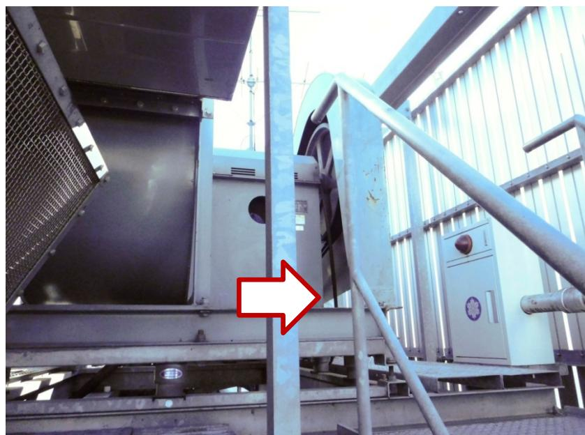
排気機の設置の状況（写真ではVベルトが脱落しております。この場合は、機器の損傷であると判断して「要是正」と判定して下さい。）
